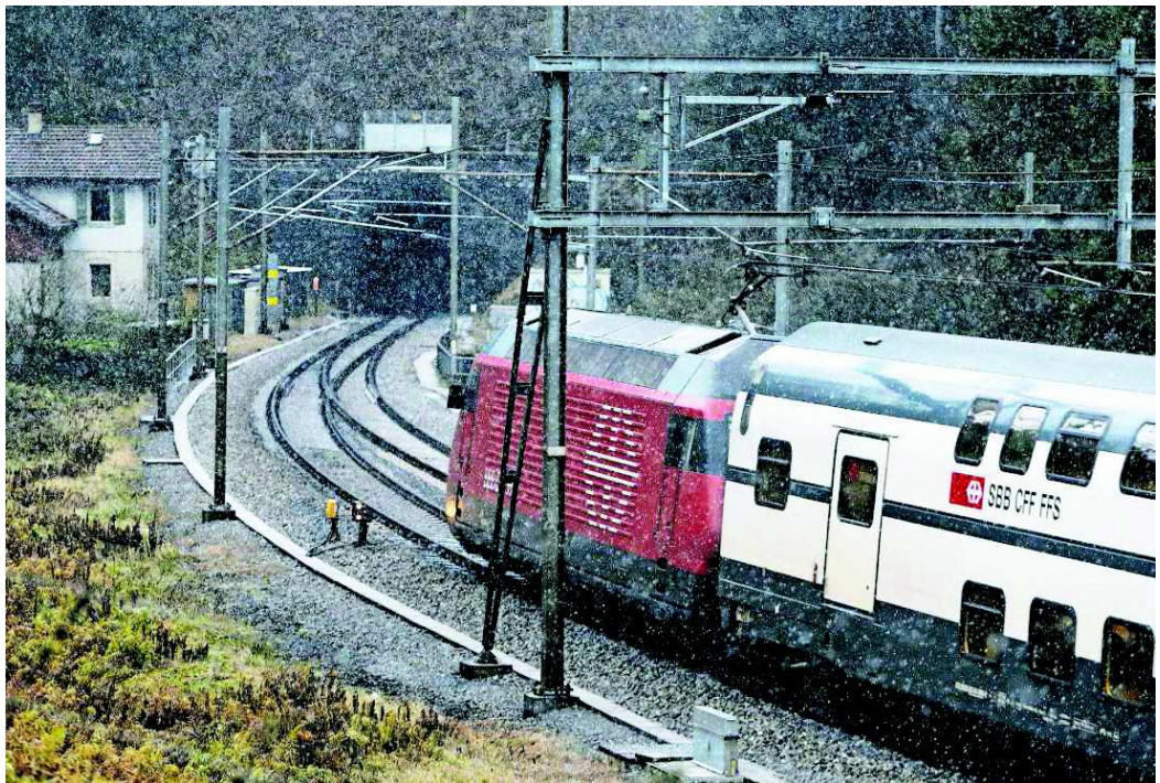
Ein Interregio-Zug der SBB fährt in den Albistunnel in Baar.
